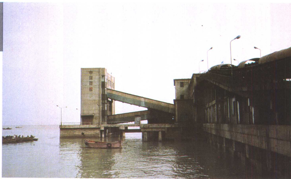
连云港庙岭码头商检煤炭自动化取 制样设备及控制楼外景
