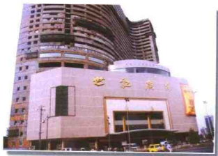
把中小企业作为基本客户，重点扶持地方政府的重点项目。图为具有典型示范效应的在建工程。
