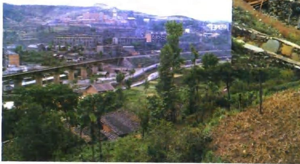
后所煤矿大庆井工业广场
