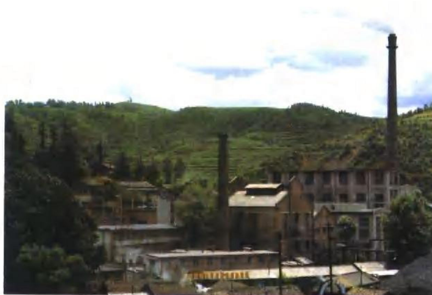
2×6000 千瓦羊场煤矿 研石电厂
