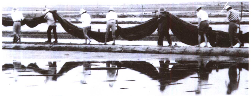
盐工在塑苫结晶池上装塑料薄膜
