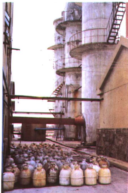
溴素生产车间及产品堆场
