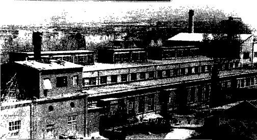
▼ 水泵厂铸工车间
