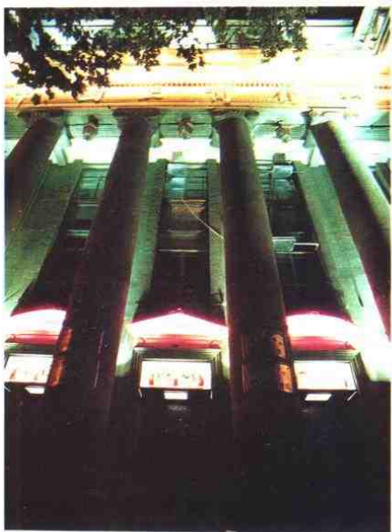
位于市中心商业区的中国工商银行南京市分行大楼
