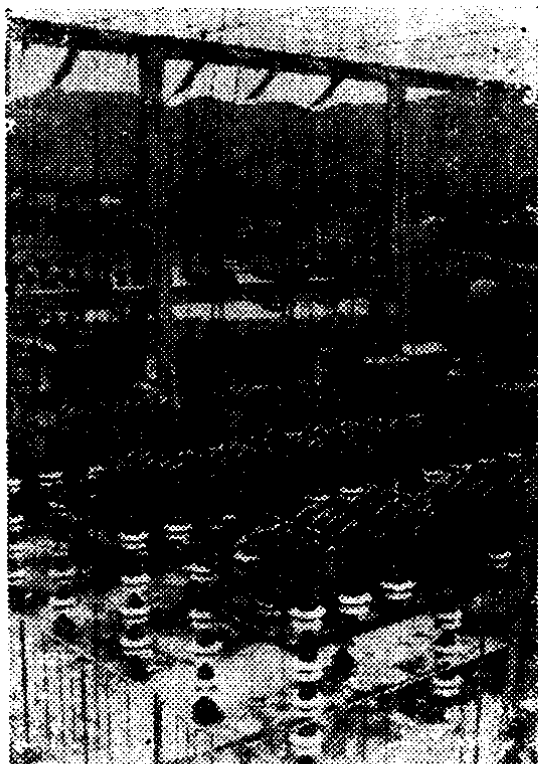
图 1 110千伏串联电容补偿装置
