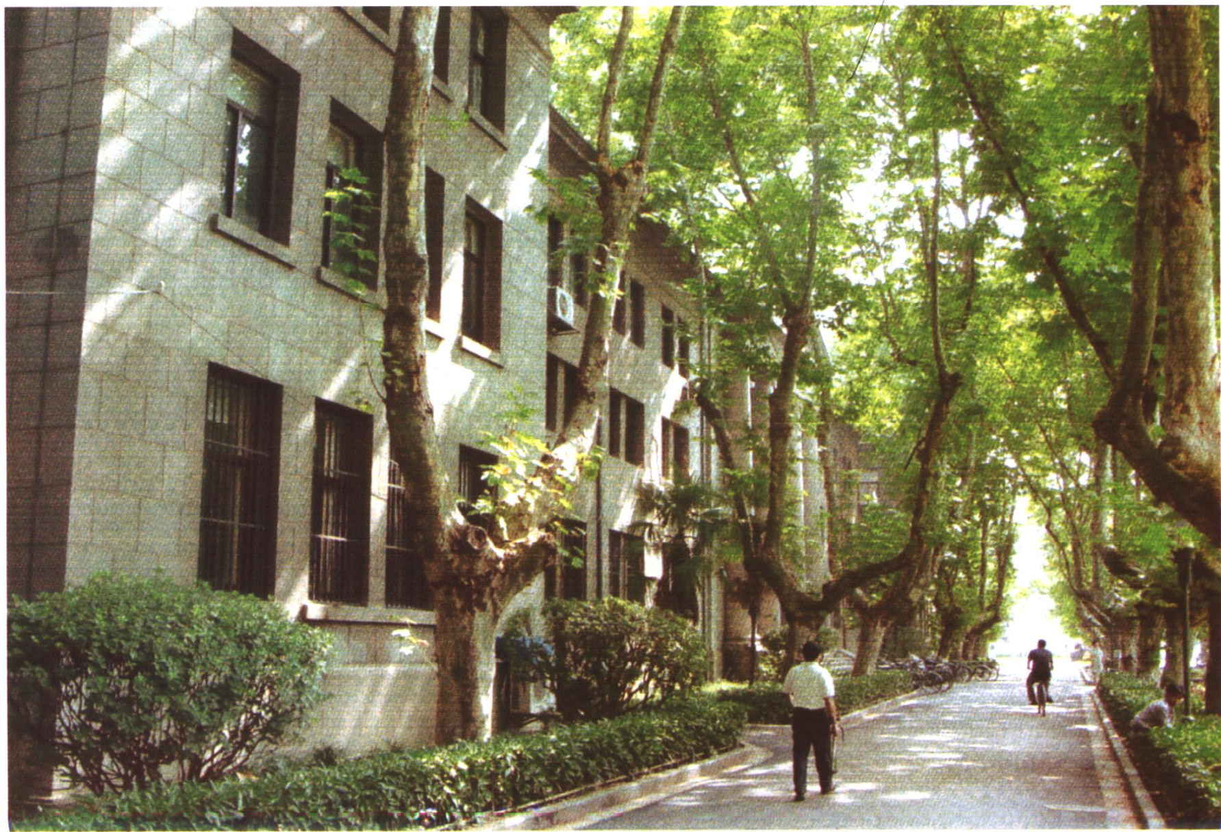
一字形建筑加建成凹形建筑的全貌 彩图 10
