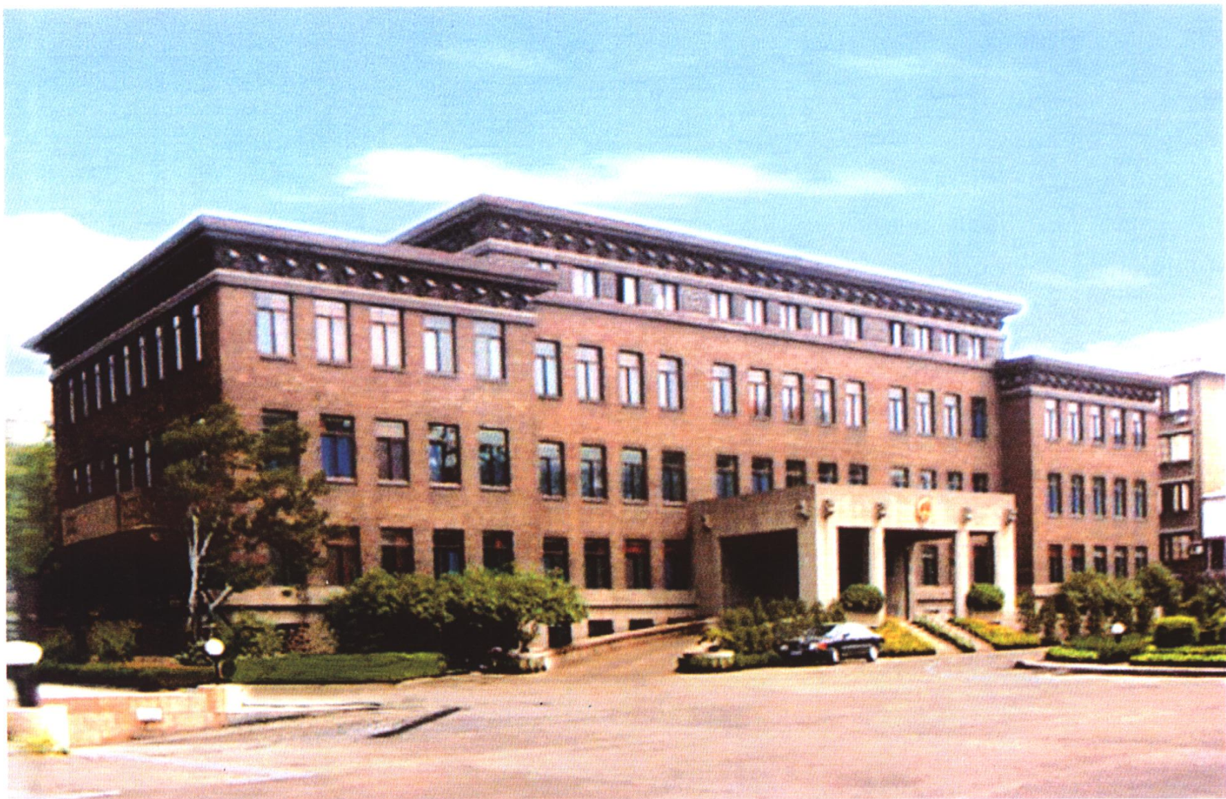
加建前的主体建筑原貌 彩图 13
