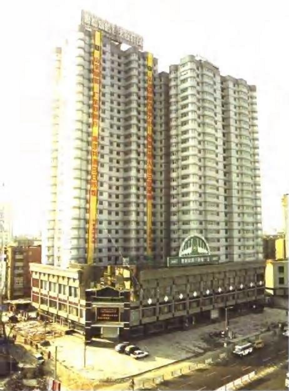
◀ 由山东三箭置业集团有限公司承建的山东省电力工业局林祥大厦，高39层，建筑面积6万平方米，被评为优质工程。
