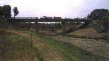
安(阳)大 (清)公路 冯 宿大桥
