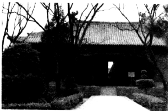
山西芮城永乐宫龙虎殿元代过路戏台
