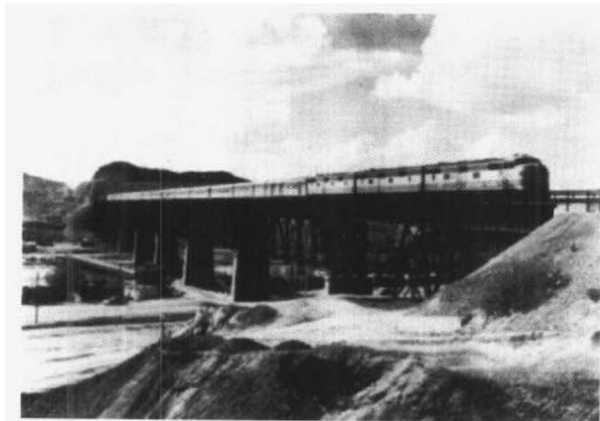
埃尔帕索市的格兰德河铁路桥 美国铁道协会供图
