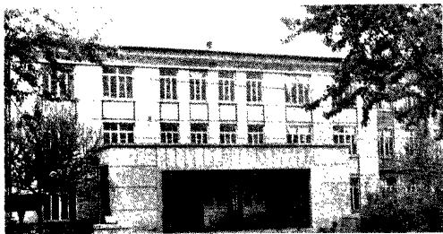
图为瓦房店市第六中学 1975 年新建教学楼
