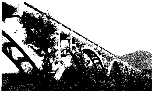
瓦房店市“长虹”渡槽
