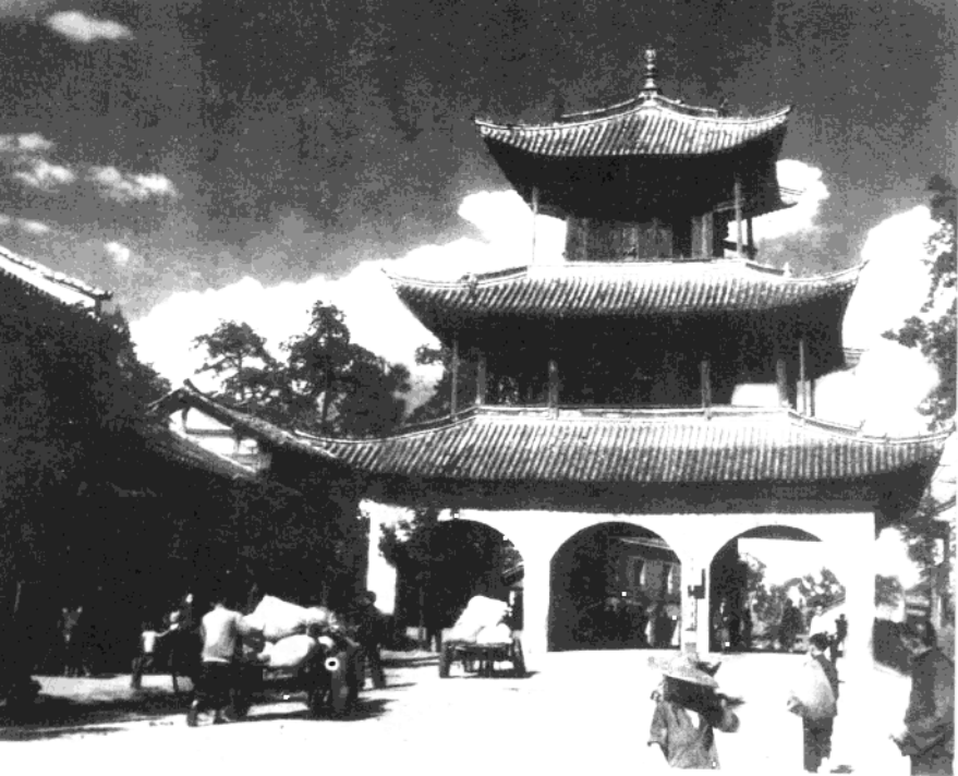
拓东路上状元楼 白塔路上古白塔
