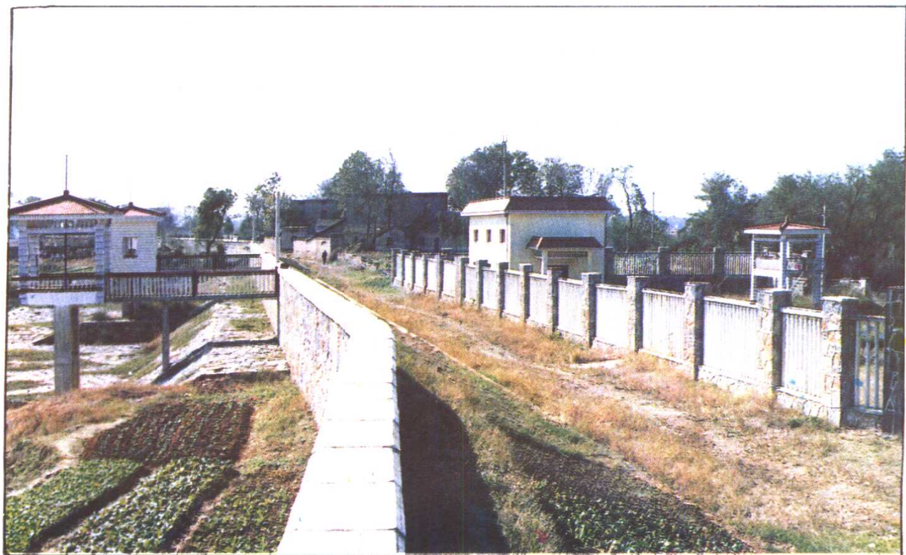
南陵县思姑桥排涝站
