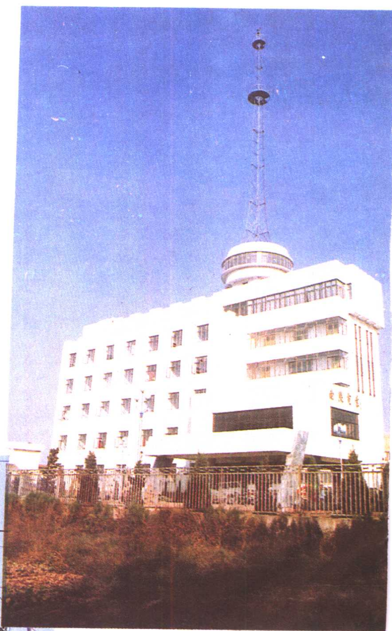
南陵县供电局办公楼
