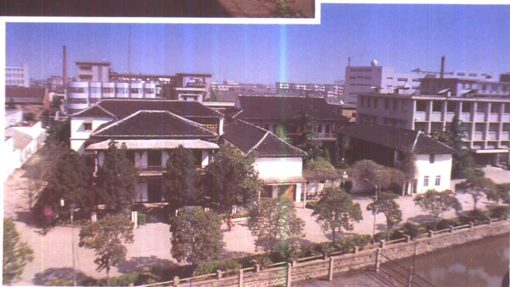
张謇在公司内的 办公楼
