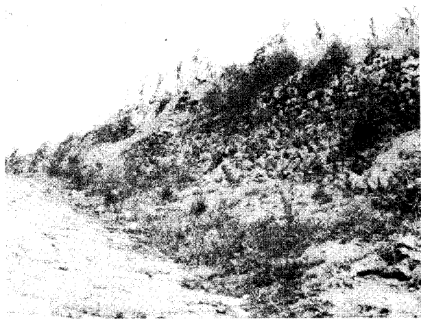
图为用废坩锅垒成的农田边墙。
