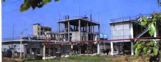
南昌农药厂嘧啶氧磷工地
