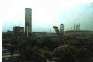
江西第二化肥厂尿素车间
