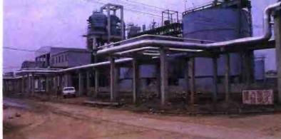
贵溪化肥厂引进的磷酸生产装置
