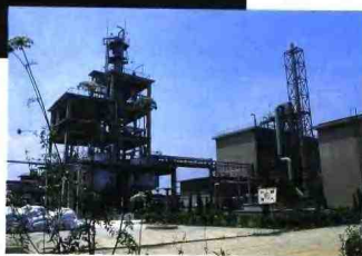
九江化工厂 2 万吨聚氯乙烯车间
