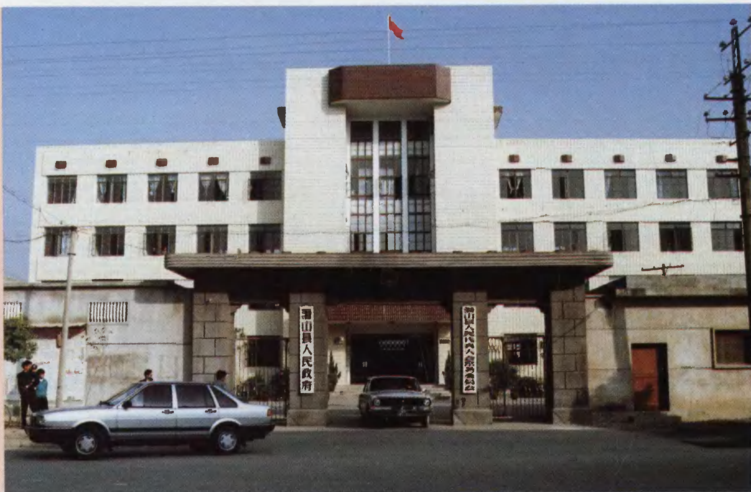
潜山县人大常委会、潜山县人民政府 机关办公楼
