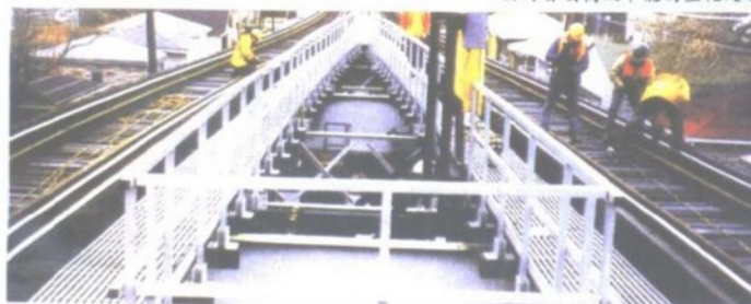
引进意大利先进技术和设备生产的玻璃钢挤拉电缆桥架
