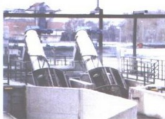
运行中的2套R01型螺旋格栅机 栅隙: 6MM, 10MM, 12MM 处理量: 298—9900M 3 /H/单机
