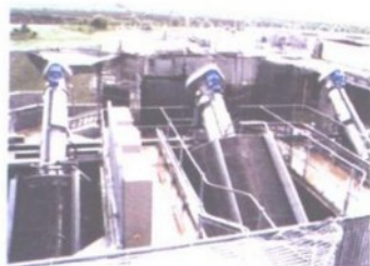
运行中的3套R02型楔形细栅机 栅隙: 0.5—5MM 处理量: 70—8200M 3 /H/单机
