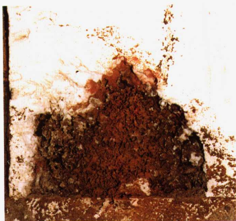
彩图 70 台湾乳白蚁在泡沫塑料隔热墙中筑巢
