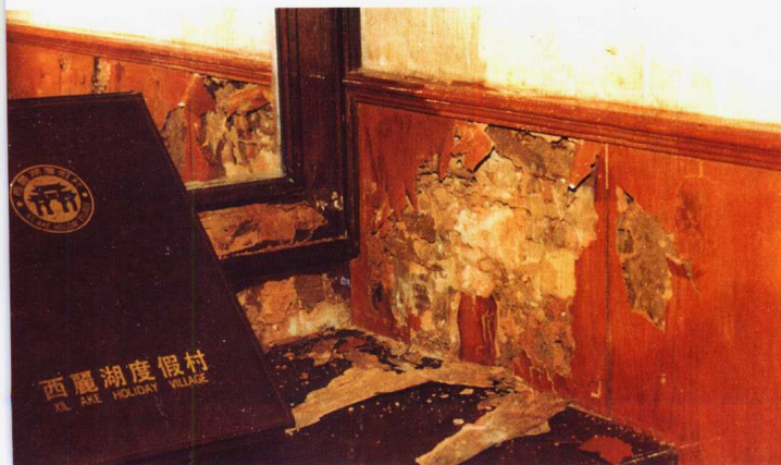
彩图11 深圳西丽湖高级宾馆木墙裙被黄翅大白蚁蛀食得破烂不堪
