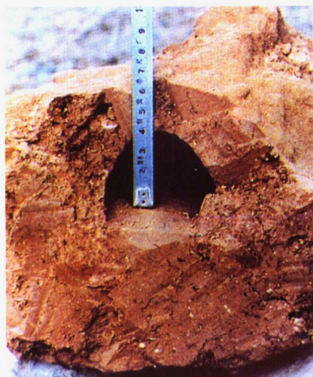
彩图 52 黑翅土白蚁在堤坝内可筑 4cm × 6cm 的隧道
