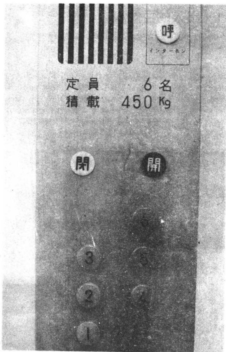
圖說：電梯的標示板上，左方有關的按鈕(閉)，右方有開的按鈕(開)。右上方有呼叫按鈕(呼)，在緊急情況使用。
