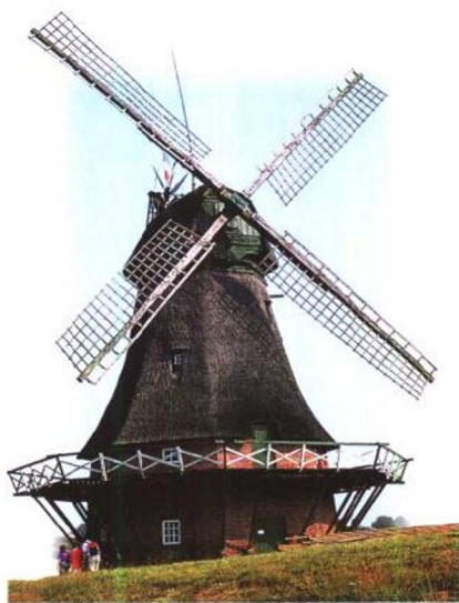
风车是最早代替人力的动力机械之一。为了有效地工作，风车装有一套复杂的转向装置使风车的风叶始终正对着风向。
