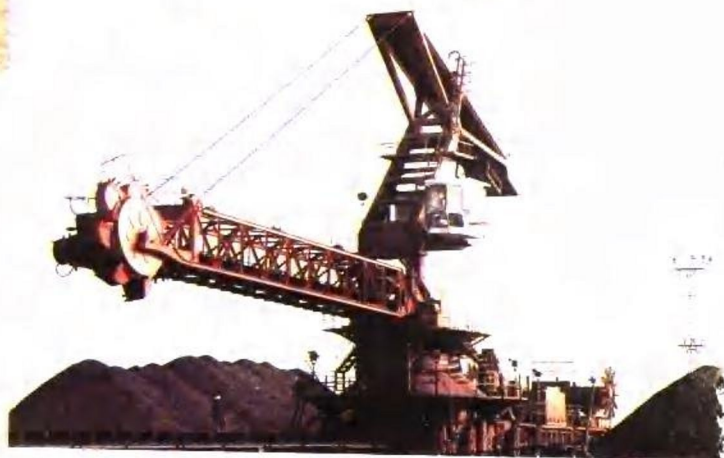
黄骅港装煤机械
