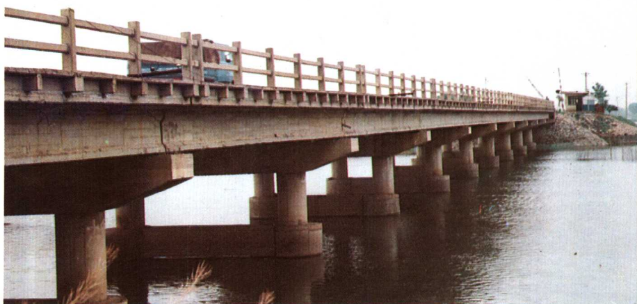
(23) 澥河公路大桥
