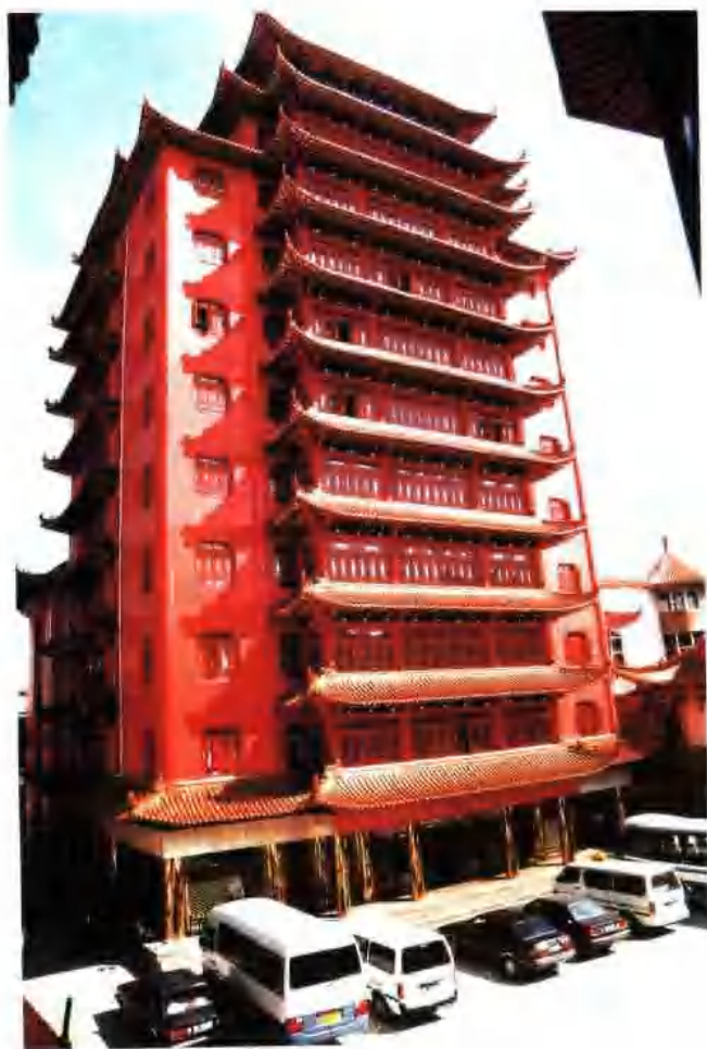
浙江东方集团公司办公大楼
