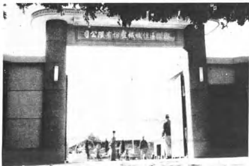
▲民國四十五年「建隆電器廠」更名為「國際通信機械股份有限公司」(即台灣松下電器公司現址)
