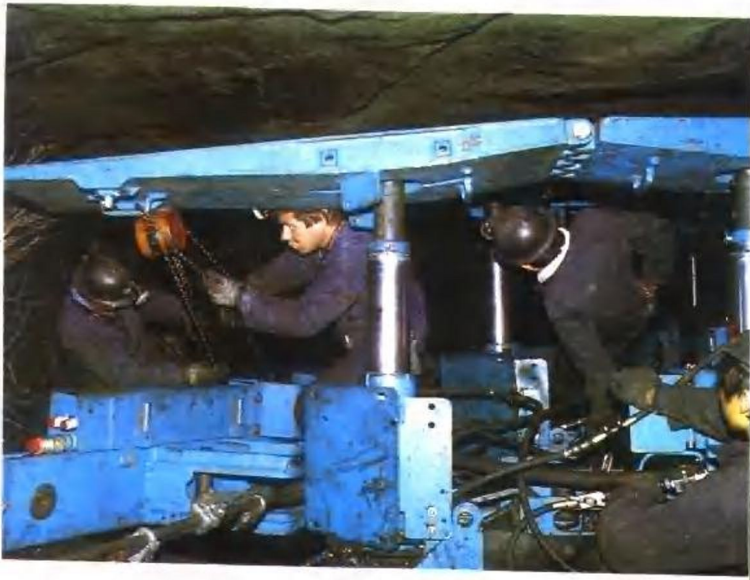
▲从西班牙引进的急倾斜综采机组在安装调试
