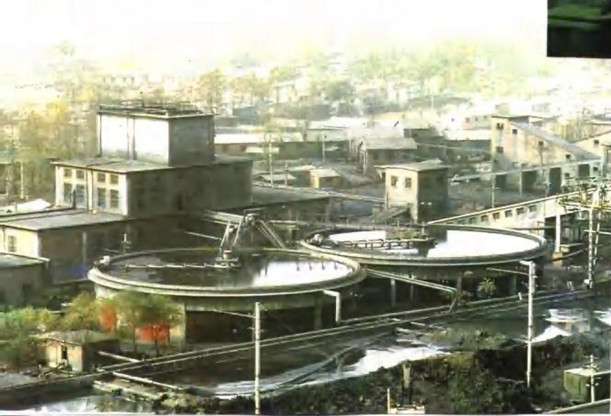
▼房山煤矿水采煤沉淀池及煤仓
