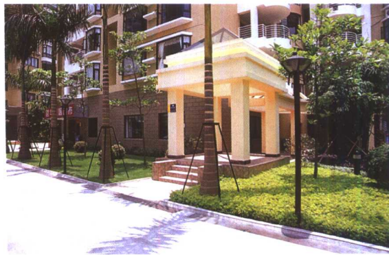
环绕住宅楼底层的连廊入口
