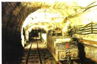
矿务局东矿平硐双道巷电机车在运行
