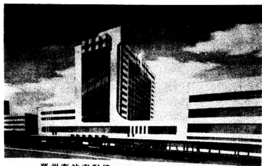
郑州客站南配楼
