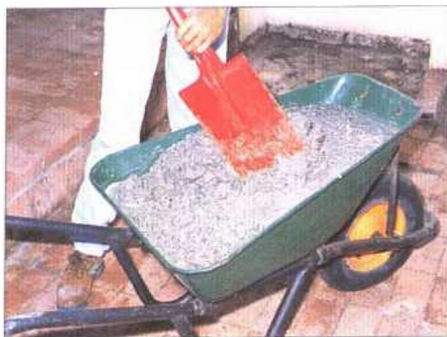
一把用于搅拌混凝土的铁锹。
