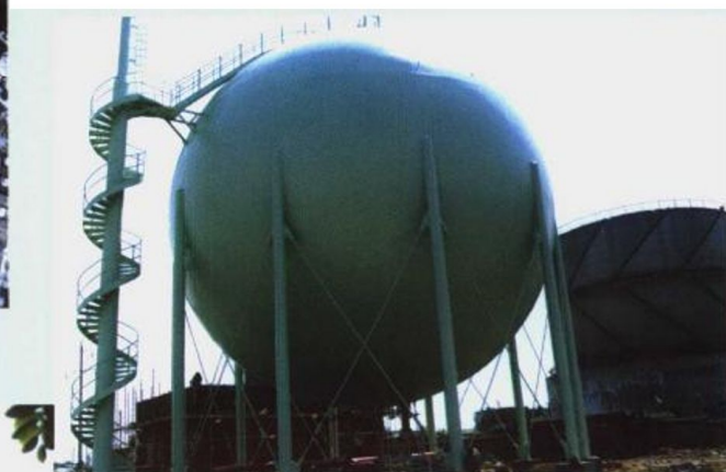
中日双方合作开发铁法煤层气回收利用示范项目总投资 10070 万美元。图为该项目的球型储气罐
