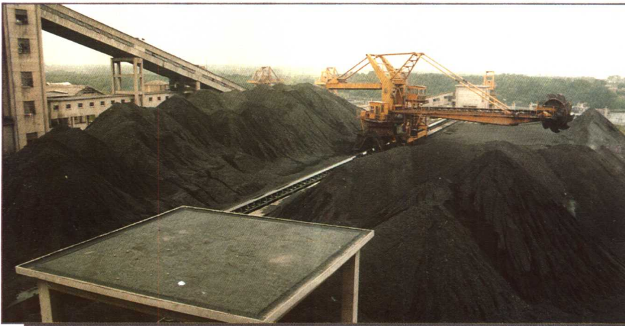
20万千瓦机组煤场。
