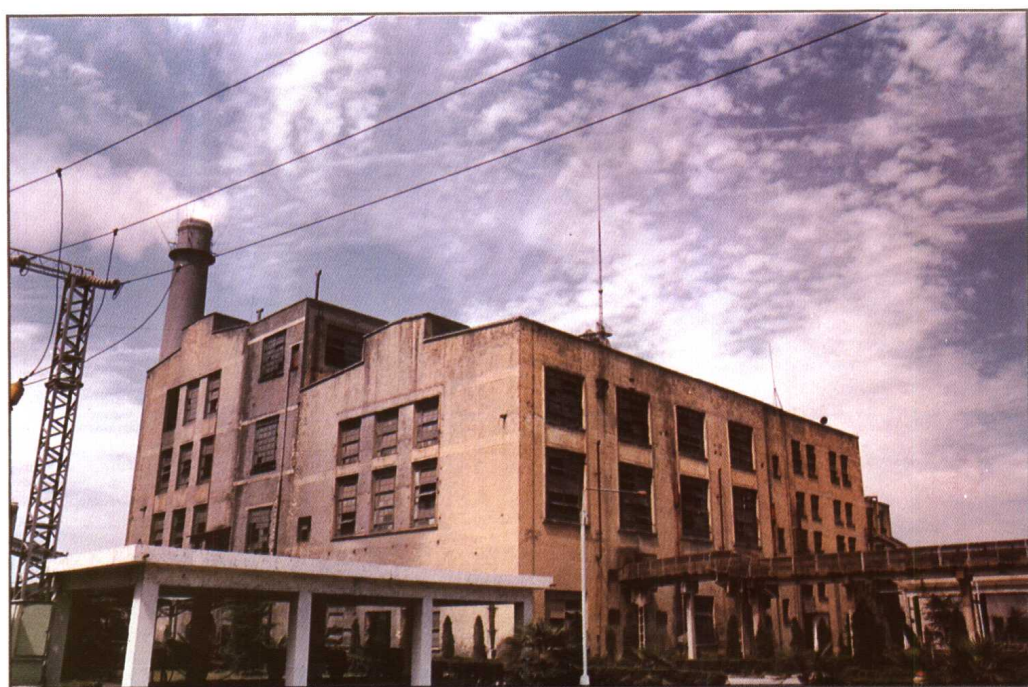
三台1.2万千瓦机组主厂房外貌。
