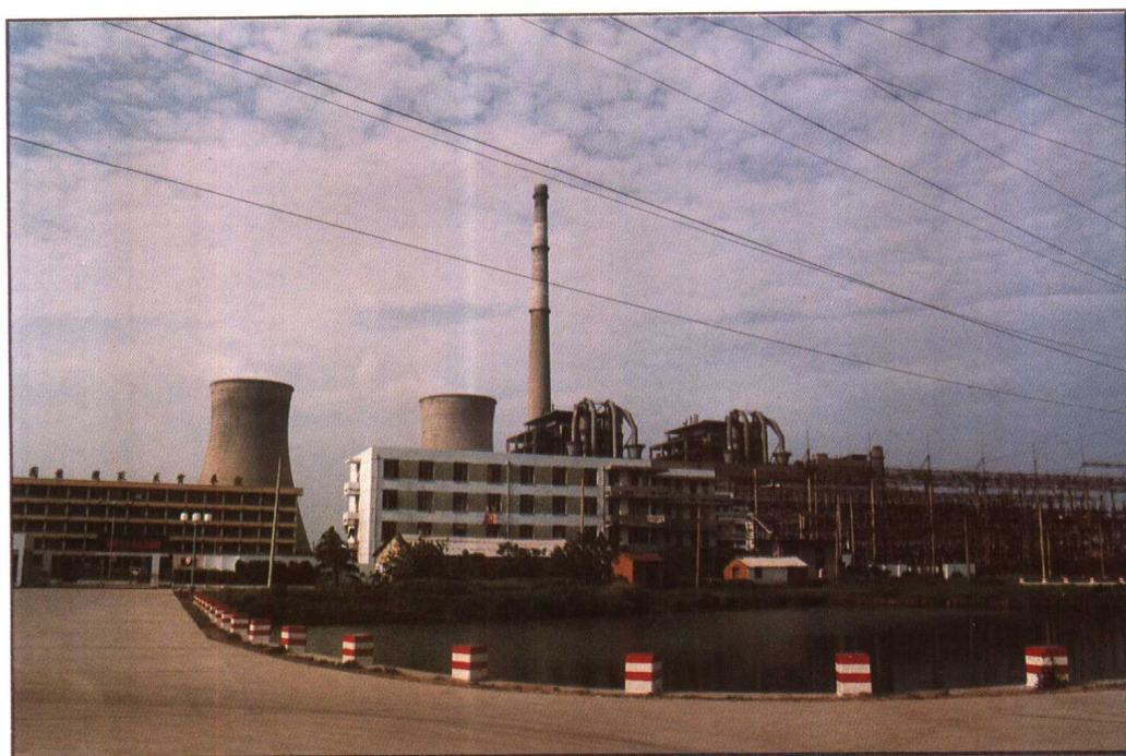
两台20万千瓦机组厂房外貌。
