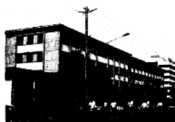
中建六局三公司厂貌
