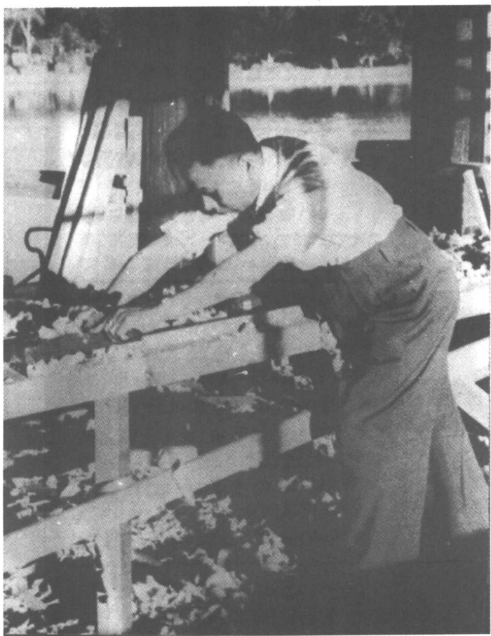
在中南海散步时，看到迎薰亭正在修缮，便走进去重操木工活 (1951年夏)
