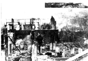
日机轰炸后的城市顿成一片废墟。
