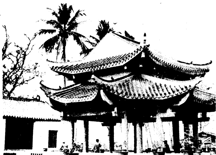
修葺一新的东坡书院载酒亭(一九八五年)
