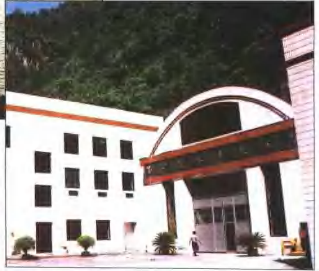
百丈漈水电站
