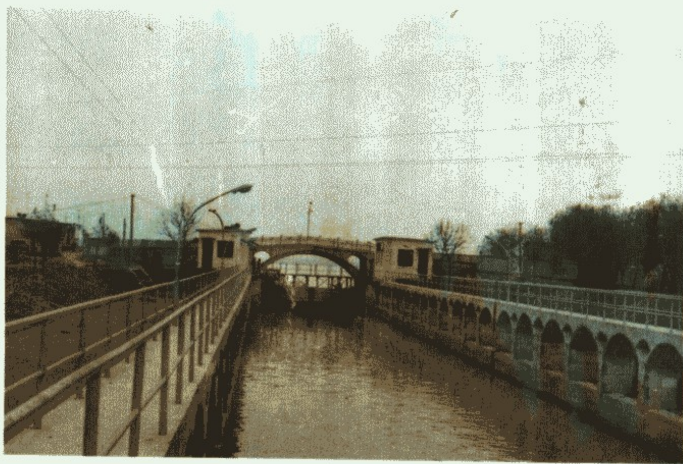
皖东水利枢纽工程女山湖大闸船闸
