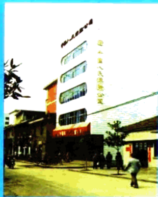
中国人民保险公司信阳市 支公司办公楼
