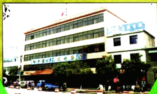
中国人民建设银行信阳市支行办公楼
