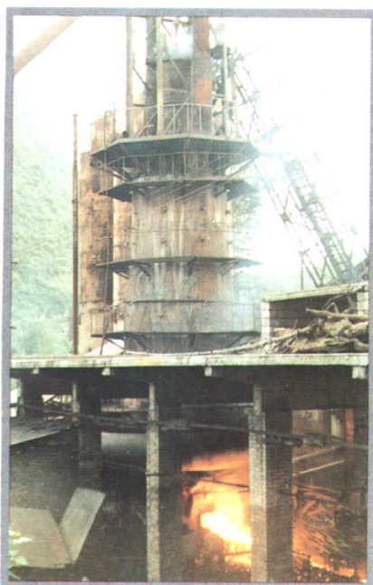
县铁厂高炉车间一角
