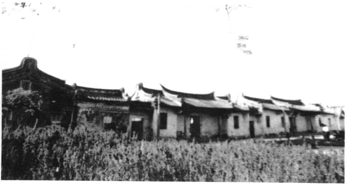
图5 “驷马拖车”住宅全景
