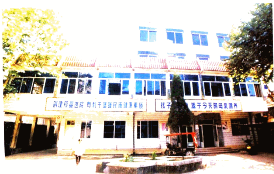
文成县人民医院门诊部
