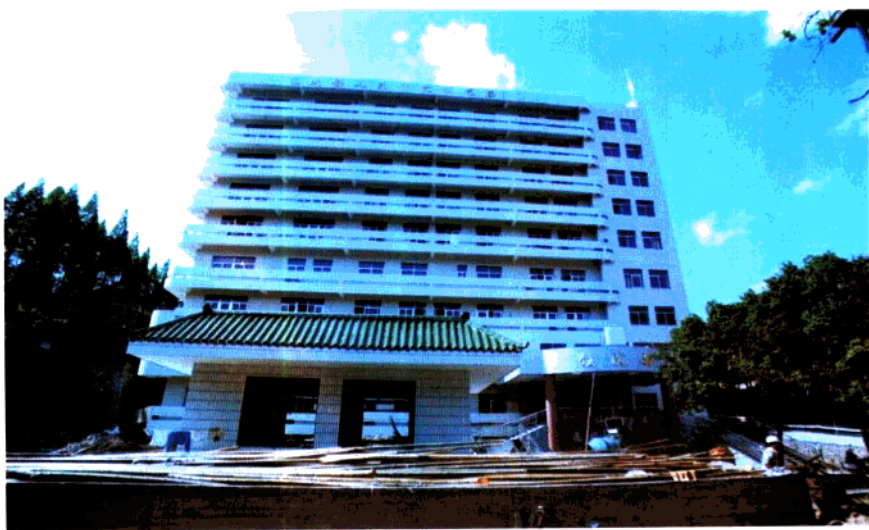
文成县人民医院住院部
