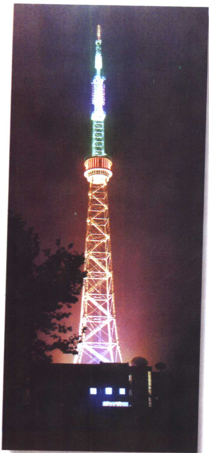
165 米高的县级电视发射塔
