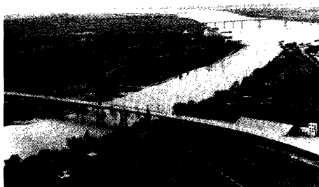
珠江三角洲农村过去渡口繁多 交通不便 如今处处桥梁相接。图为番禺市沙区水网地带的桥梁公路。
