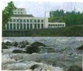
安图三〇一水电站
