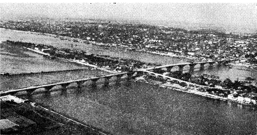
长沙湘江大桥，是一座大型 双曲拱桥，主桥全长1250米
