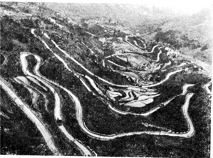
川黔公路盘山路全景
