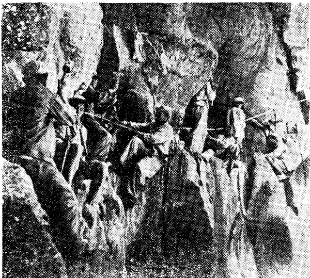
英雄的筑路战士正 在怒江两岸的悬崖 陡壁上修筑川藏公 路
