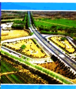
怀柔县101公路立交桥
