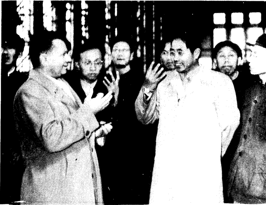
3. 刘秀峰同志视察正在建设中的富拉尔基重型机器厂水压机车间
